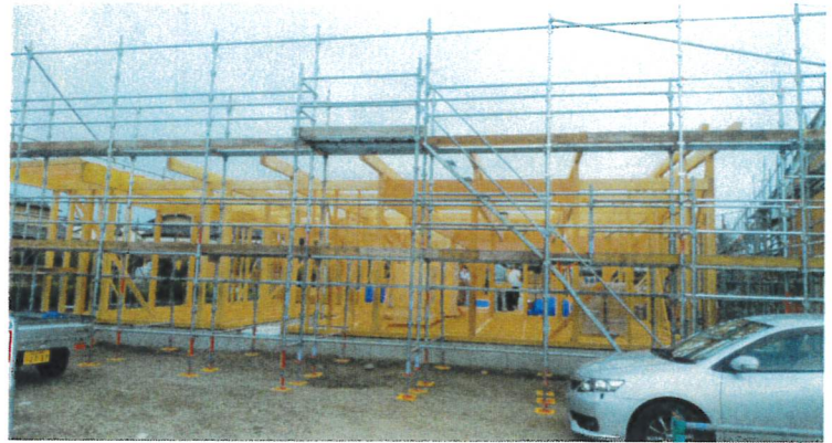
上棟式前、建設中の公民館(北側より撮影)
